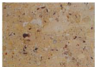
A1713 刷洗面 ACID TREATMENT
